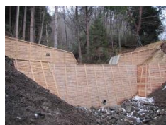
治山事業の残存型枠での間伐材利用 (岩手県宮古市)
