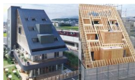
木造非住宅建築物
