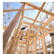
TOKYO WOODの家建築の様子
