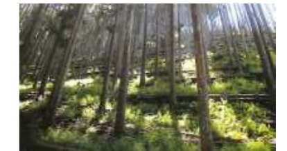
間伐・筋工の設置
