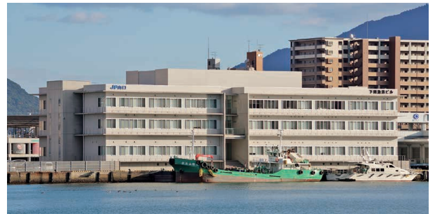
【下関漁港ビル】
