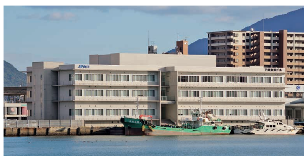
【下関漁港ビル】
