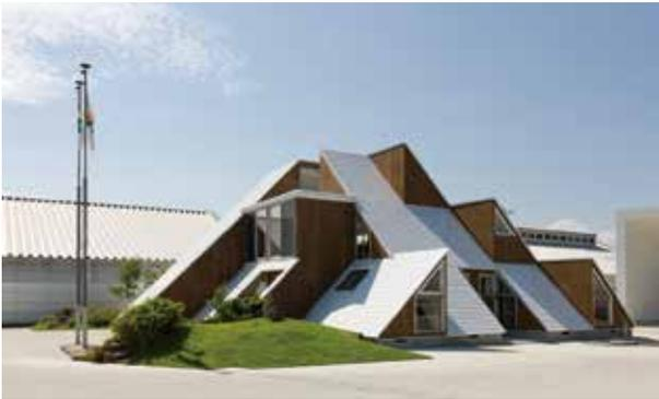
1997(平成9)年、本社を山形市に新築移転。地上3階、高さ16mのKES構法による大空間オフィスで、グッドデザイン賞を受賞した。木造の法定耐用年数は事務所が24年であり今年その年数に達するが、今もお客様が玄関を入ると「木の爽やかな香りがいいですね!」と、まるで新築のよう。今後100年は利用可能だろう。耐用年数が鉄骨造34年、鉄筋コンクリート造47年だが、大断面木造建築は24年。住宅レベルの年数がそのままになっており短すぎる。鉄骨造のように材料の太さで変えるべきである。
