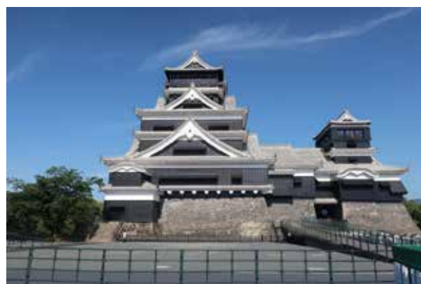
熊本城天守閣 【写真提供：熊本地震デジタルアーカイブ/提供者：熊本県】
