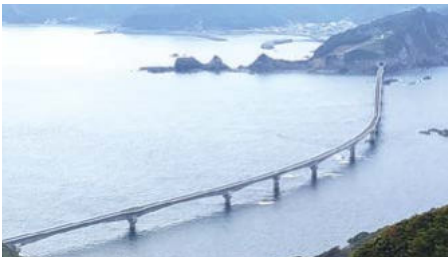
令和2年8月29日に開通した甑(こしき)大橋 (L=1,533メートル)
