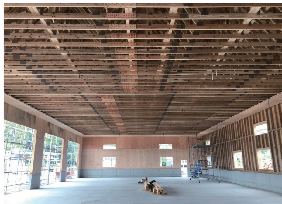
さつまファインウッド 国産2×4部材によるトラス工法で建設した木材倉庫(鹿児島市郡山町)
