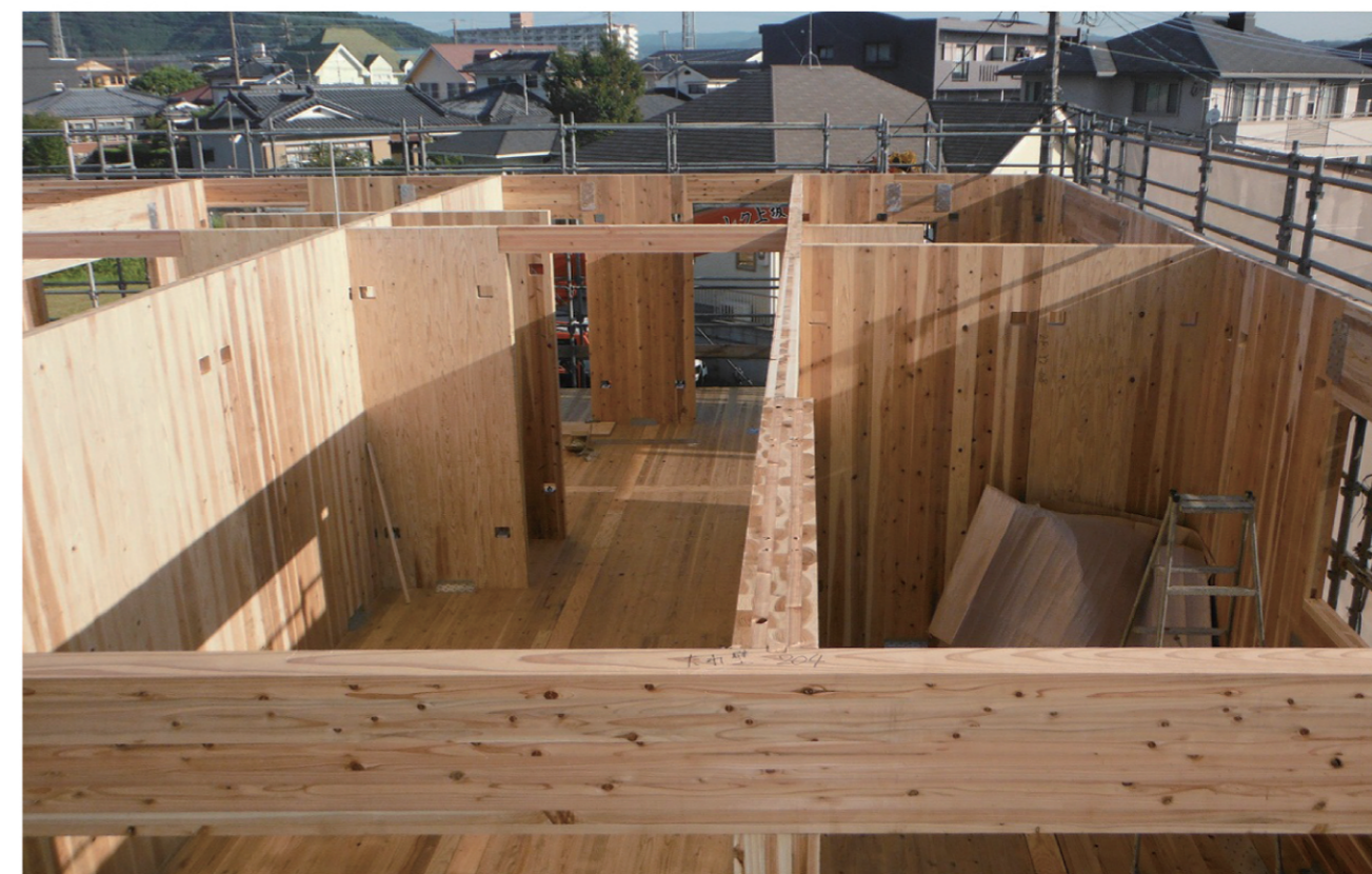
山佐木材 国産CLTを活用した4階建てアパート(鹿児島県始良市)
